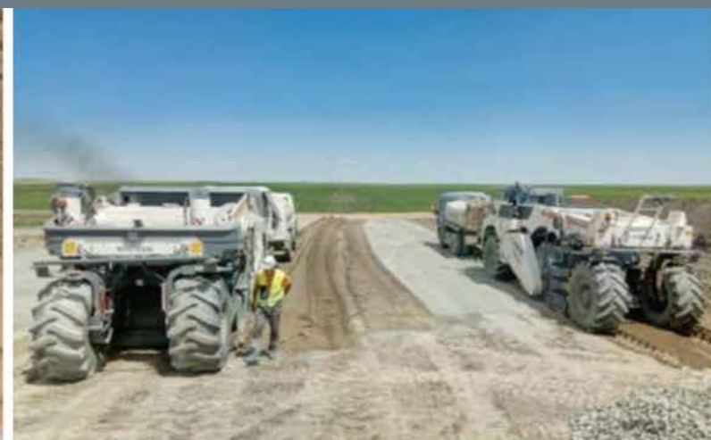
Zamešavanje tla i hidrauličnog veziva
