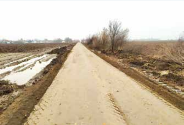
Izgled nekategorisanog puta nakon kišnog perioda, pre i posle stabilizacije Beobond-om C30.
