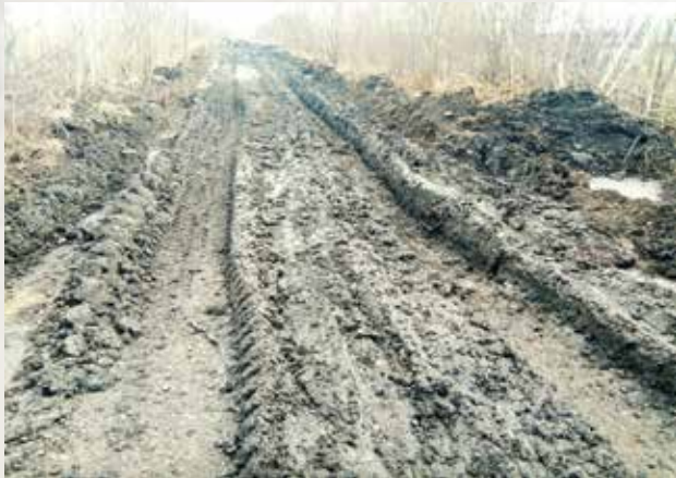
Izgled nekategorisanog puta nakon kišnog perioda, pre i posle stabilizacije Beobond-om C30.
