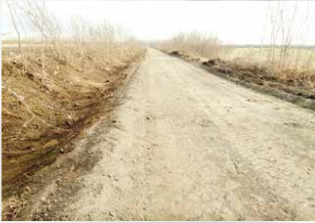
Izgled nekategorisanog puta nakon kišnog perioda, pre i posle stabilizacije Beobond-om C30.
