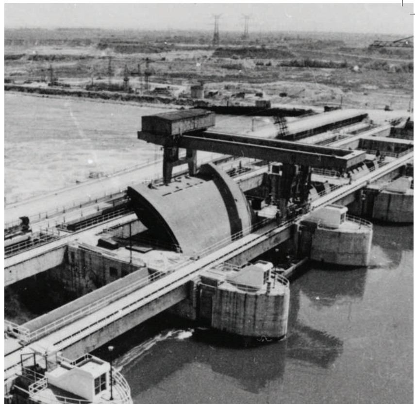
Hidroelektrana Đerdap / Hydropower Plant Đerdap
