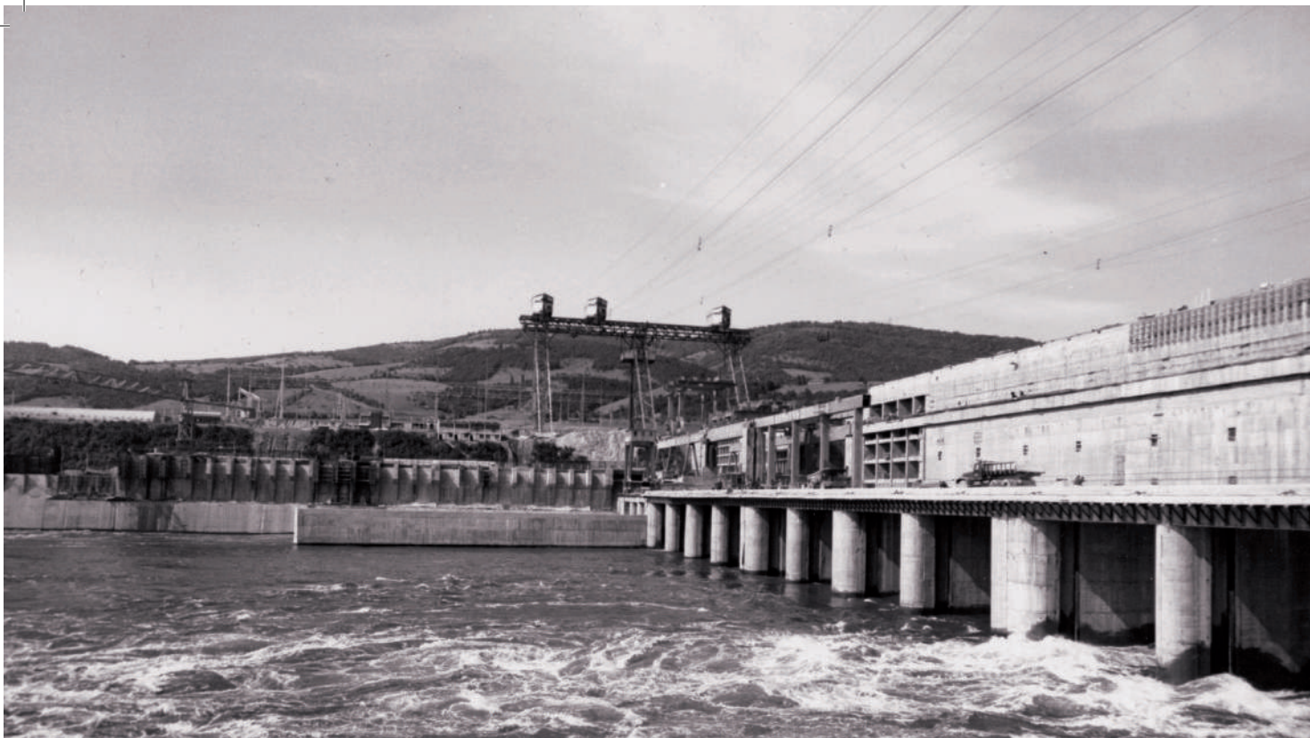
Hidroelektrana Đerdap / Hydropower Plant Đerdap
